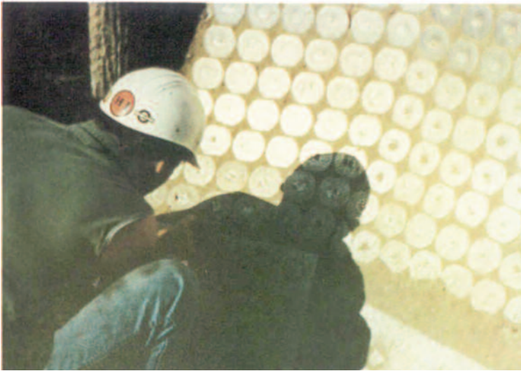
Anordnung der Scheiben bei Materialfluss in Pfeilrichtung und an gebogenen Flächen. Reihen parallel, mit ca. 10 mm Zwischenraum.
